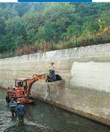
Нанасяне на Planiseal 88 с пистолет във водоелектрически канал
